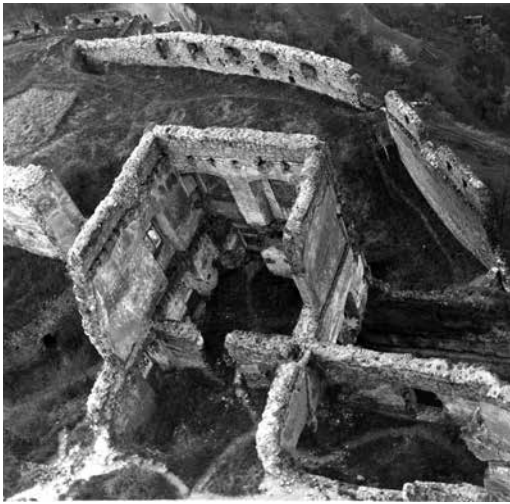
Obr. 30. Ruiny Zápoľského paláca na Trenčianskom hrade pred obnovou. Vydali F. Illek & A. Paul, želatínová fotografia, pred rokom 1937. Fotoarchív SNM v Martine, F-08547
