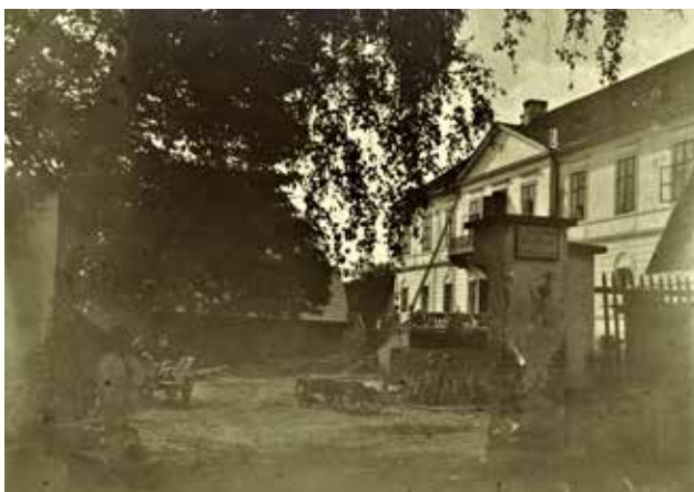
Obr. 44. V súčasnosti rozpadnutý kaštieľ v Mikšovej pri Bytči. Autor neznámy, koniec 19. až začiatok 20. storočia. Fotoarchív SNM v Martine, F-02502
