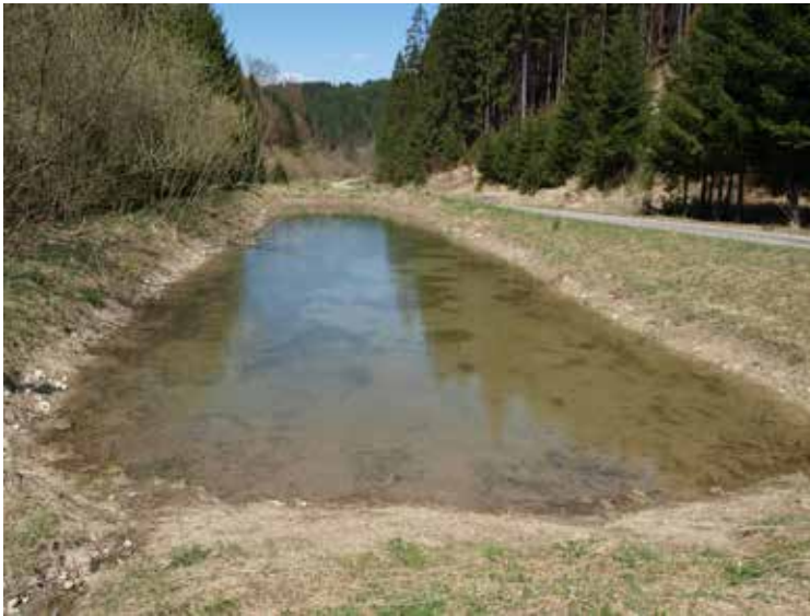
Obr. 5. Sklabinská dolina, ústie Košovej, protipovodňová hrádzka. Foto A. Astaloš, 25. 4. 2015
